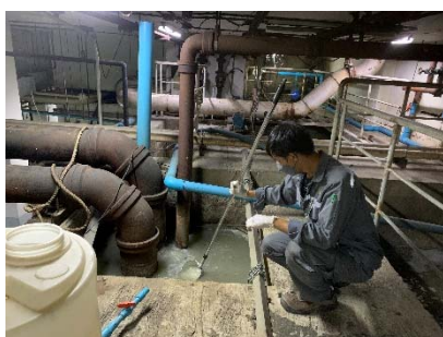
จุดรวบรวมน้ำเสียเข้าระบบบำบัดน้ำเสีย (บ่อปรับสมดุล)
